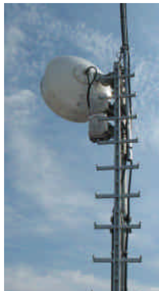
Am Flughafen: 60 cm Antenne mit zwei ODU
